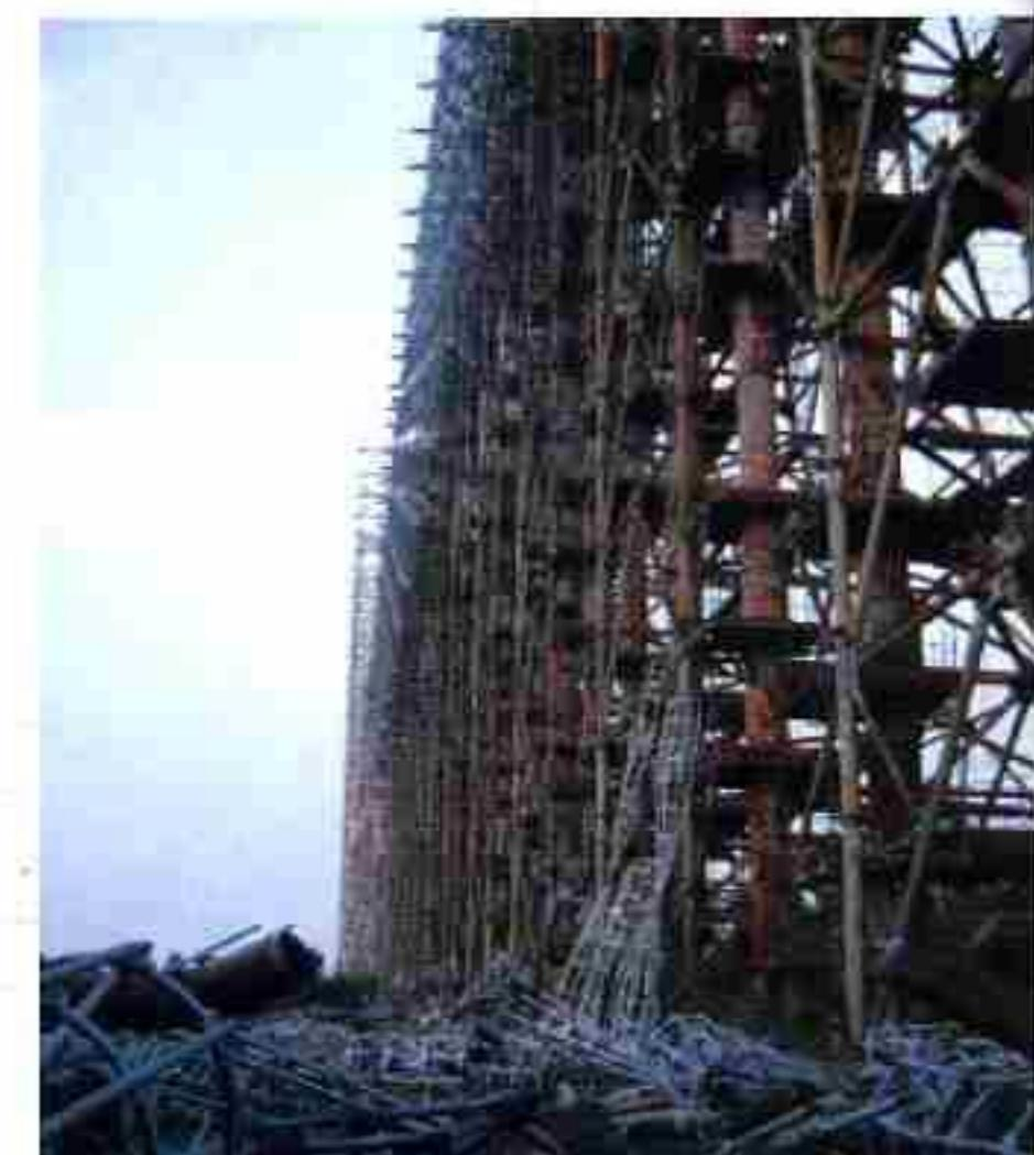
■ Осень 2007 года. Половина приемных элементов (диоплей) уже срезана. Обратите внимание на ржавчину на несущих конструкциях. А теперь посмотрите на диоплы...
