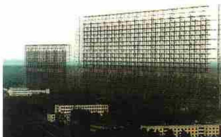
■ **ФАР, большая и малая.** Конструкция антенны предполагает прием определенного коротковолнового сигнала, плюс-минус некоторые девиации по длине волны в обе стороны. Для расширения принимаемого диапазона волн и нужна малая антenna.
